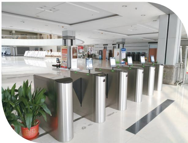
一楼东、西门，二楼南门安装门禁系统，在保留原有刷卡、刷手机入馆功能的同时，全新开通了 11 个人脸识别闸机通道。读者只需在首次使用时，携带校园卡自助拍照采集信息，成功后即可通过人脸检测直接入馆。
